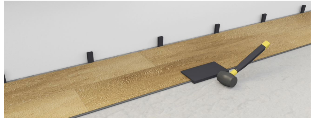
Use un martillo y un taco de goma para golpear suavemente en los lados largos de las piezas, asegurándose de que los clicks de las filas anteriores están completamente encajados. / Use a tapping block and a rubber mallet to gently tap the long sides of the planks into the click of the previous row to make sure they are fully engaged.
